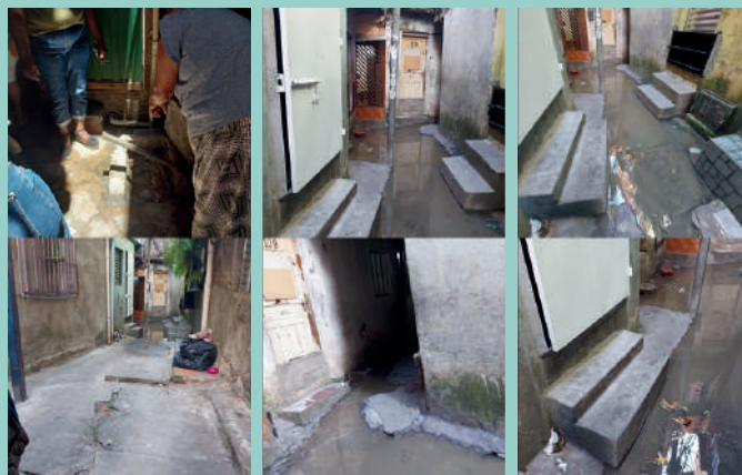
FIGURA 29. Problema de microdrenagem na viela Sta. Luzia
