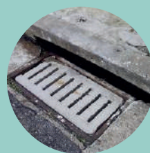
Bocas de lobo
