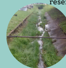
Valas de drenagem/ de infiltração
